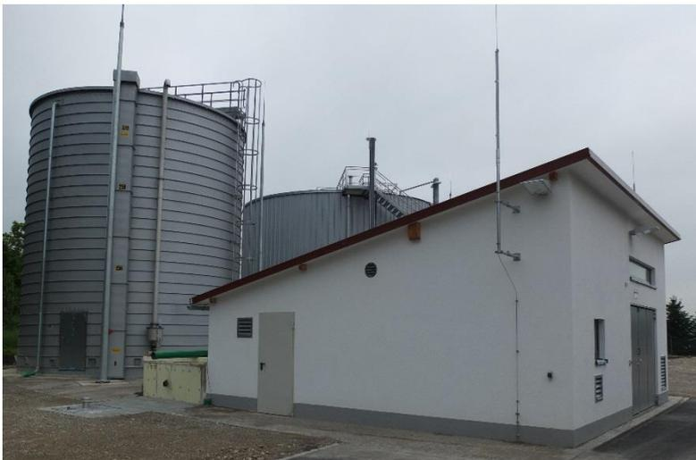
Die im Jahr 2016 in Betrieb genommene Biogasanlage auf dem Gelände der Kläranlage in Schongau. (Faulturm, Methanspeicher und Maschinenhaus)
